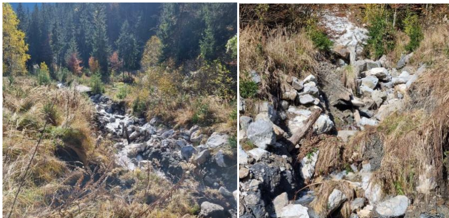
Slika 12 in 13: Uničene kinete dolvodno od razdelilnega objekta na odseku C
