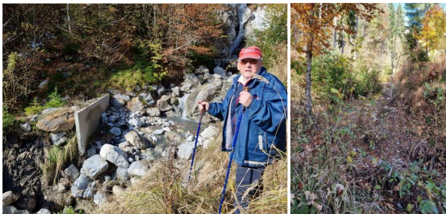
Slika 10 in 11: Uničen razdelilni objekt in prosto razlivanje hudourniške vode po gozdnih pobočjih
